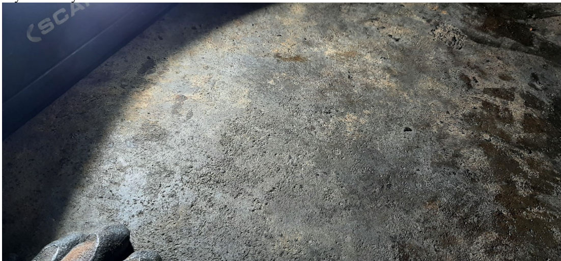
Mynd 2. Gólf er alsett pyttum +/- 0,5 – 1.5 mm djúpum í 8mm plötu
